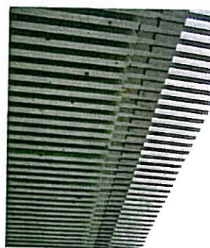
▲ ▼ La dalle bois est réalisée en planches vissées sur chant, portée ponctuellement par des rideaux de planches d'épicéa.
